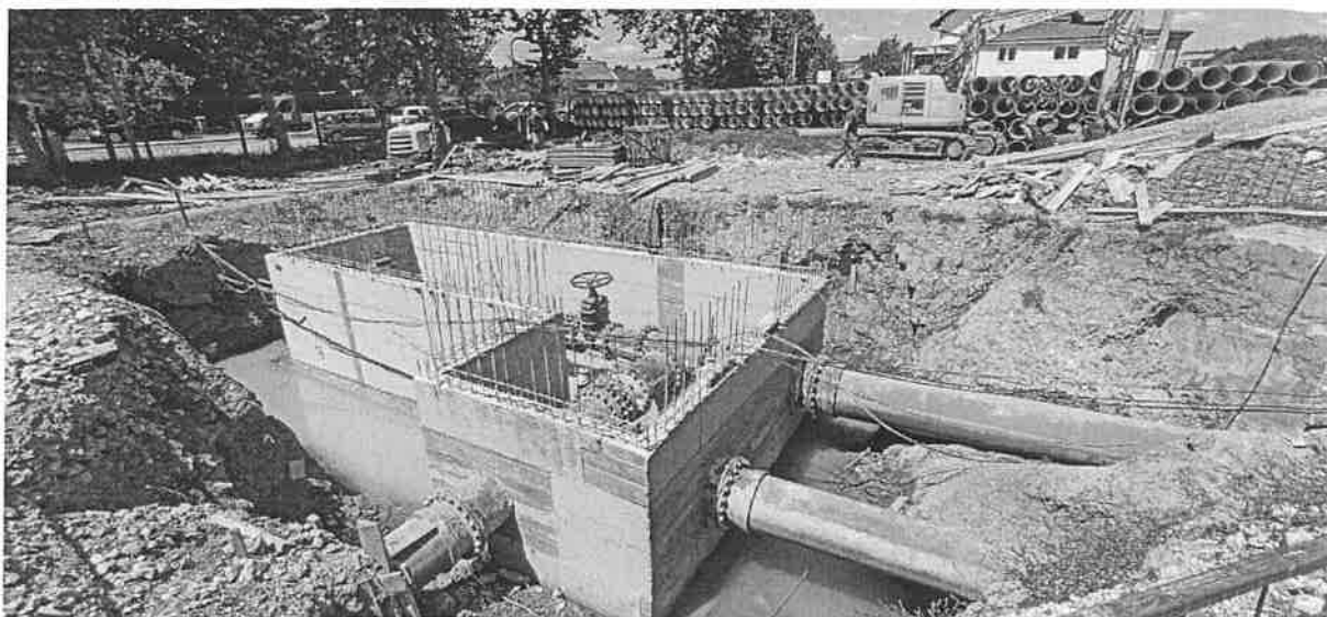
Slika 6. Okno u krugu PS „Spreča“ (betonirani zidovi okna)
