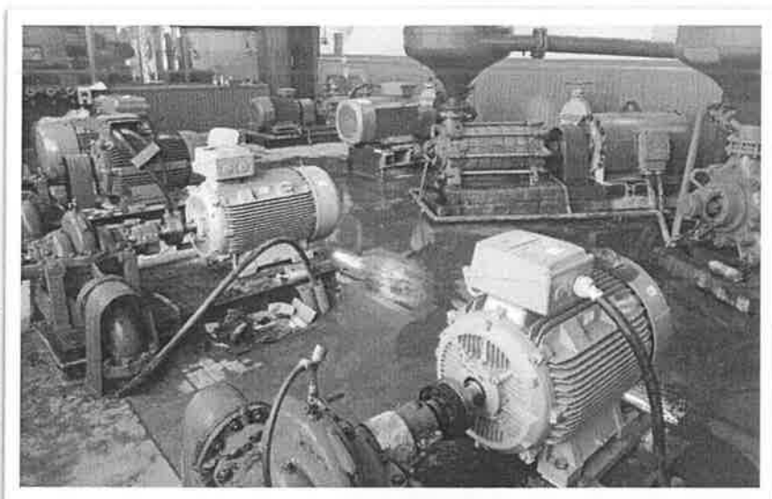
Slika 10. Stanje pumpne stanice prije i u toku sanacije
