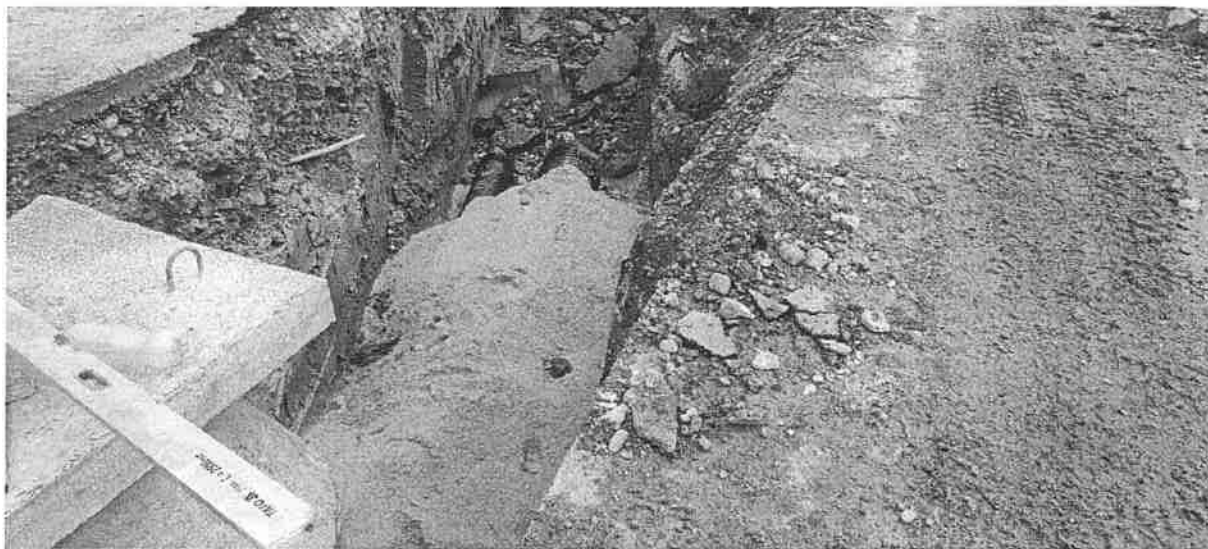
Slika 11. Izvođenje radova na lokaciji Pecara 2 – vodovodna mreža
