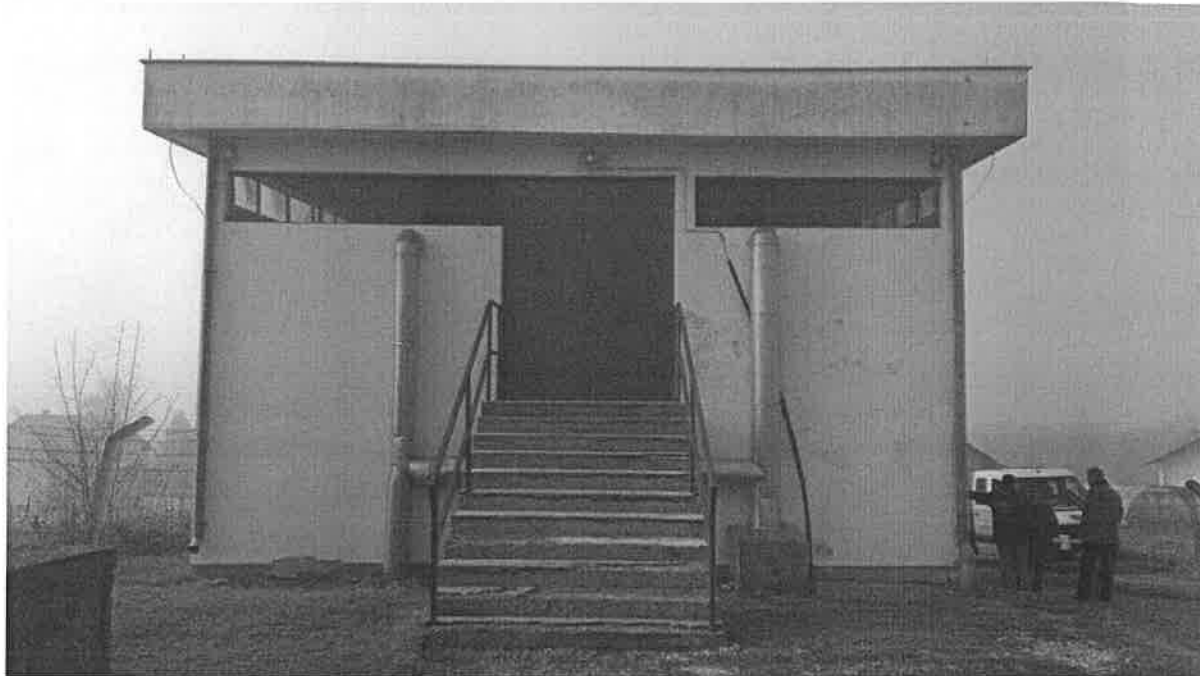
Slika 6. Postrojenje u Dobrnji
