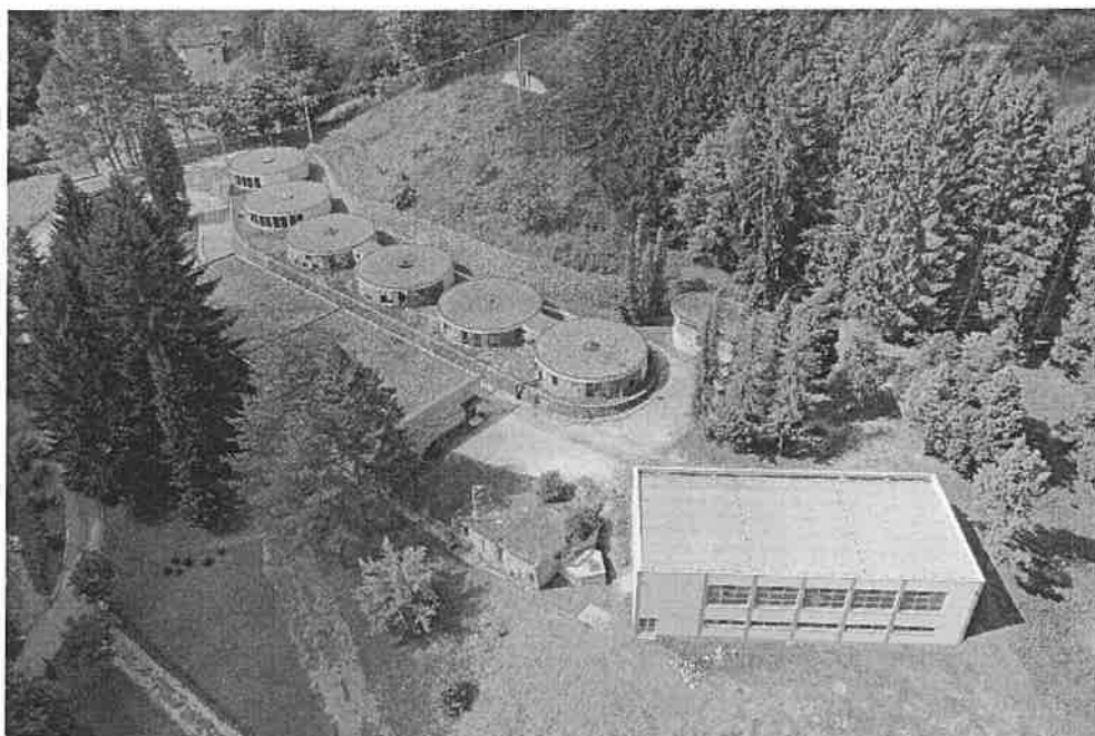
Slika 2. Nadogradnja postrojenja u Stuparima- slika iz zraka
