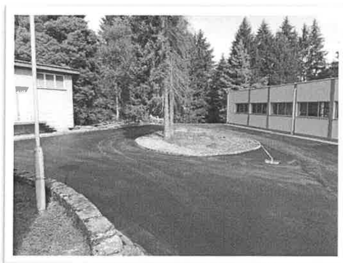
Slika 14. Asfaltiranje kruga pogona za proizvodnju vode Stupari
