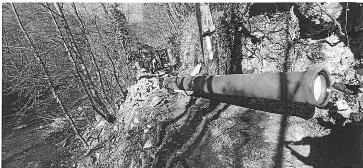
Slika 1. Izgradnja cjevovoda ductil DN 500mm POV Stupari-PS Spreča
