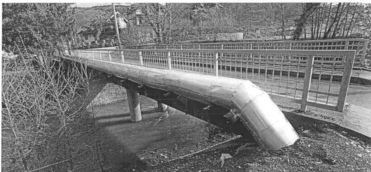
Slika 4. Oblaganje cjevovoda
