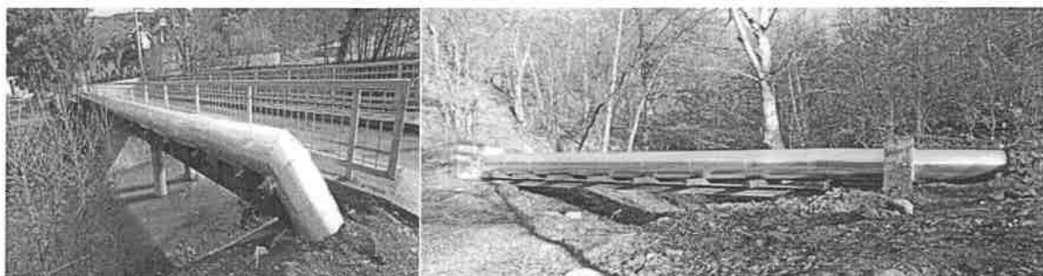
Slika 2.1. Ugradnja toplotne izolacije za dijelove cjevovoda koji su polagani iznad zemlje
