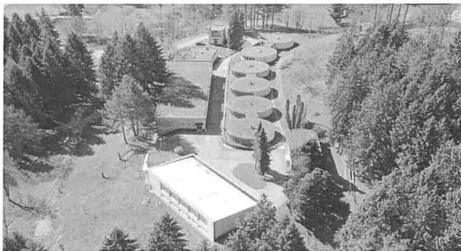
Slika1. Nadogradnja postrojenja u Stuparima- slika iz zraka
