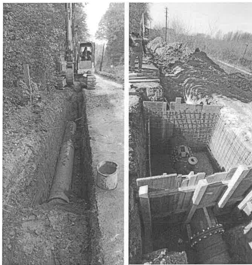
Slika 5. Radovi na polaganju cijevi ductil DN 500mm
