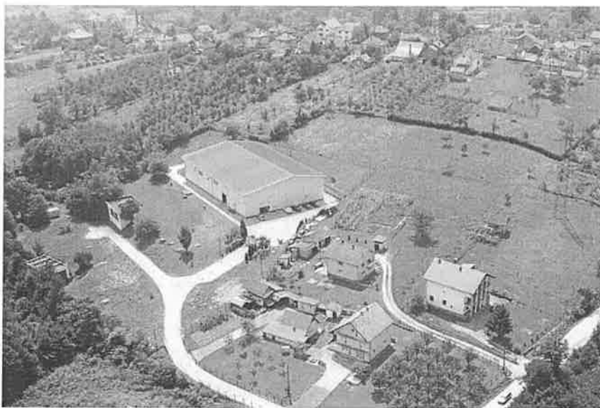
Slika 5. Postrojenje za interventno snabdijevanje Grada vodom na Ceriku
