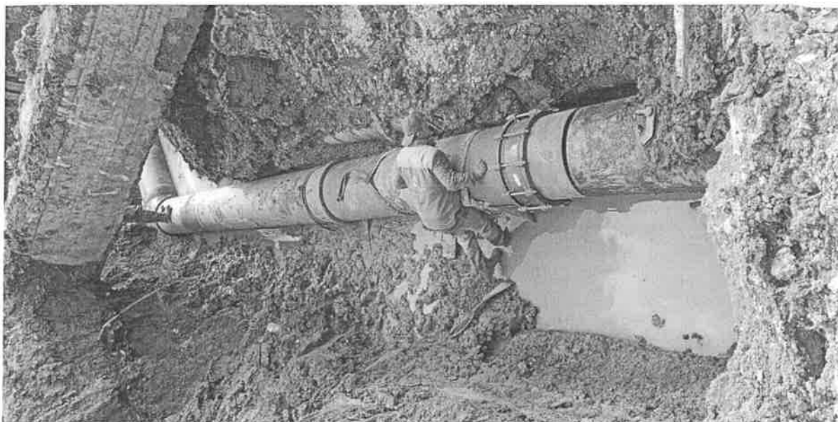
Slika 3. Spoj novog cjevovoda sa postojećim u krugu PS Spreča
