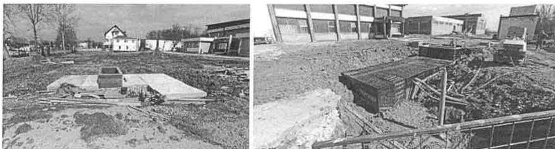
Slika 4. Završni radovi na izgradnji spojnih okana u krugu PS Spreča
