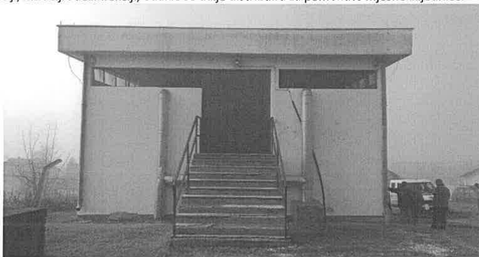
Slika 4. Postrojenje u Dobrnji
