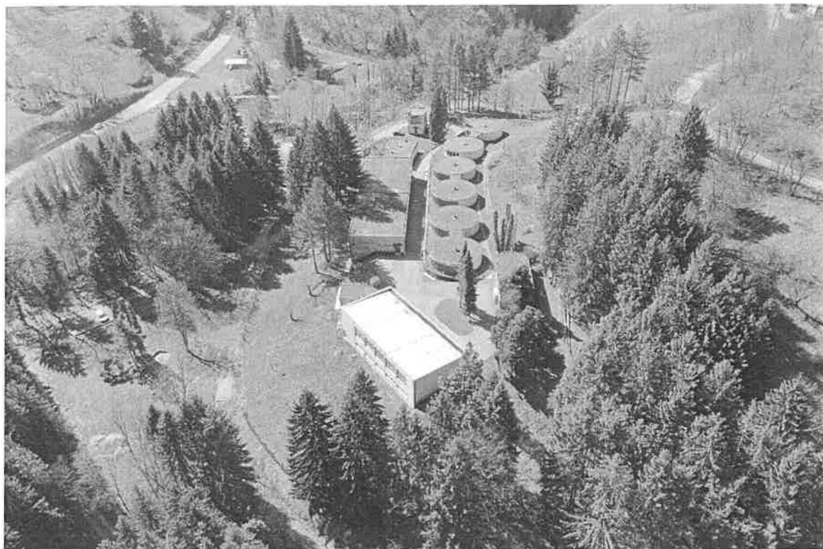
Slika 7 Postrojenje Stupari nakon radova
