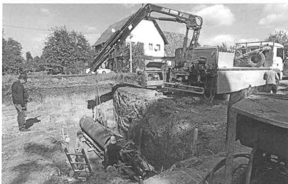
Slika 6. Utiskivanje čelične zaštitne cijevi DN 800mm u trup pruge, željeznička stanica Ljubače
