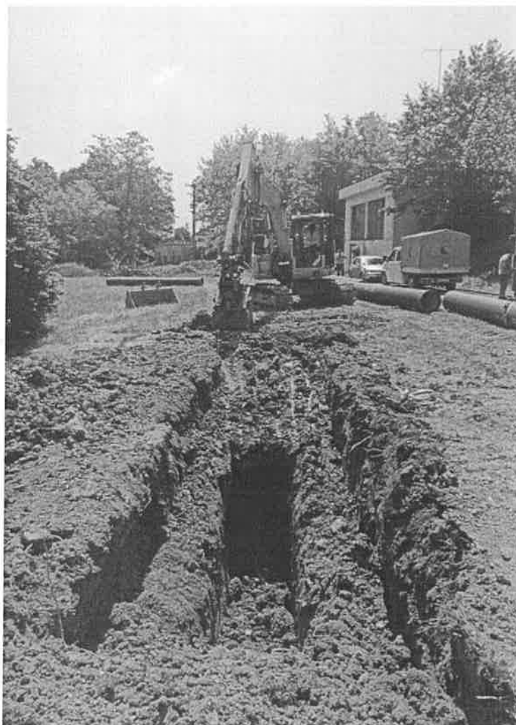
Slika 7. Radovi na polaganju cijevi u krugu R Cerik
