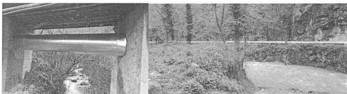
Slika 2.2 Ugradnja toplotne izolacije za dijelove cjevovoda koji su polagani iznad zemlje
