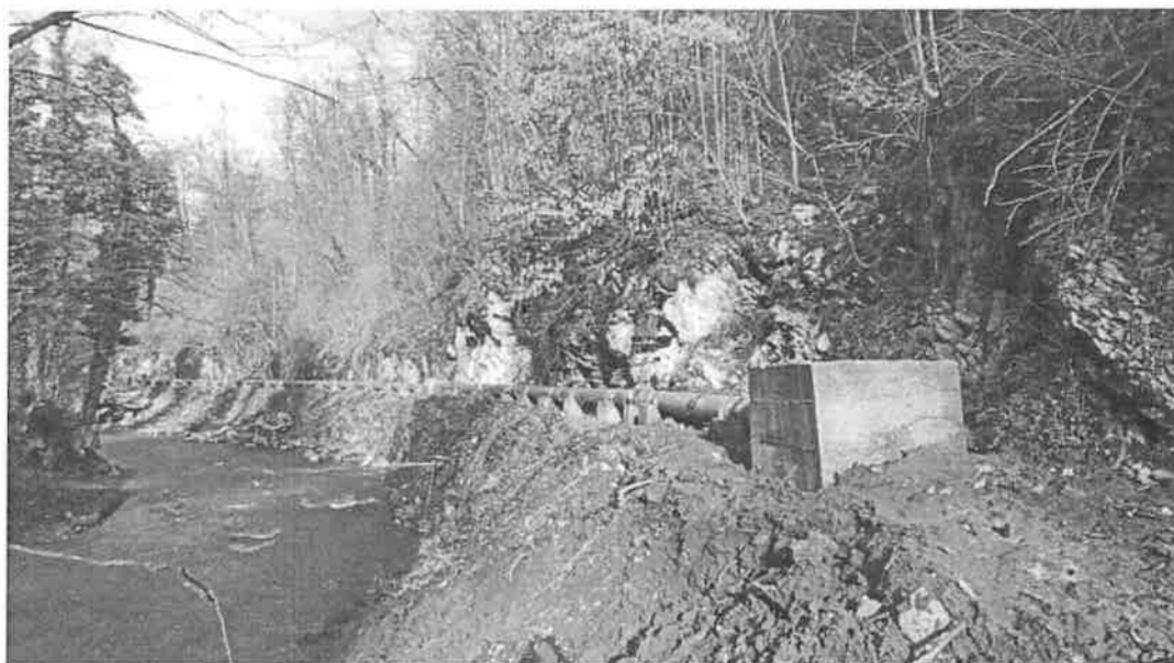
Slika 1. Izgradnja cjevovoda ductil DN 500mm POV Stupari-PS Spreča u kanjonu rijeke Gostelje
