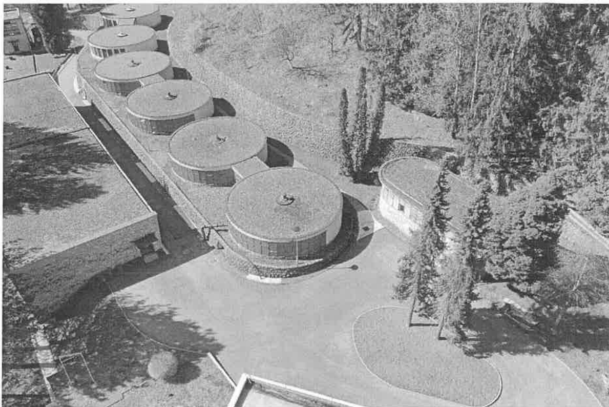
Slika 2 – Postrojenje za obradu pitke vode “Stupari”
