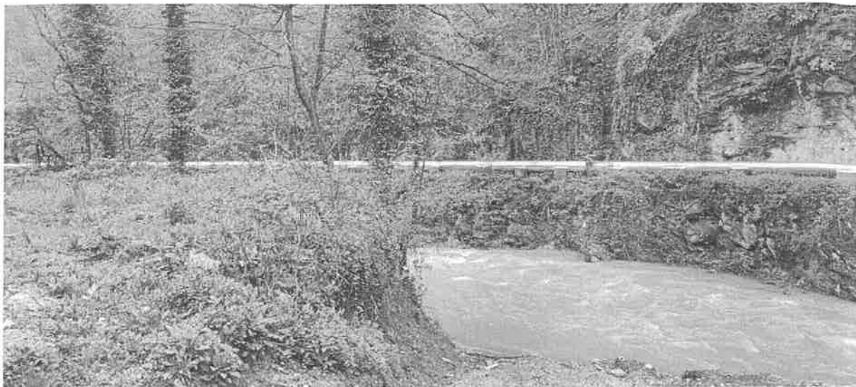
Slika 1. Izgrađeni cjevovod ductil DN 500mm POV Stupari-PS Spreča u kanjonu rijeke Gostelje
