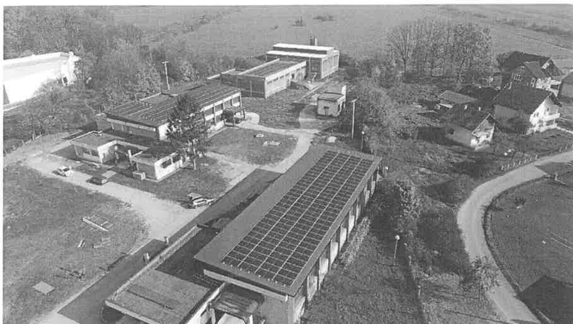
Slika 3. PS Spreča – 3x 50kW solarne elektrane
