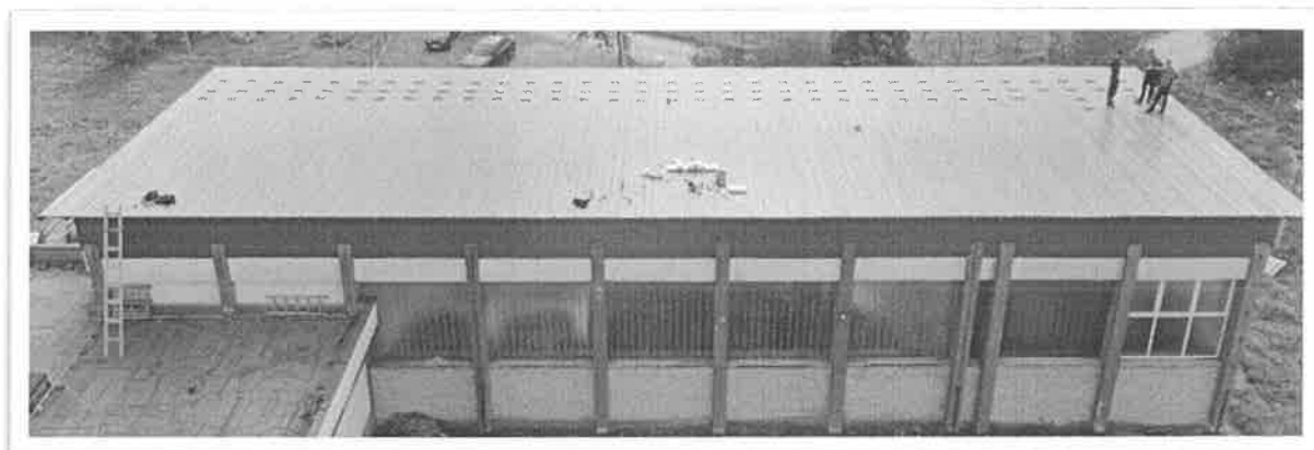
Slika 3: Izgled novoizgrađenog krova na objektu deferizacije
