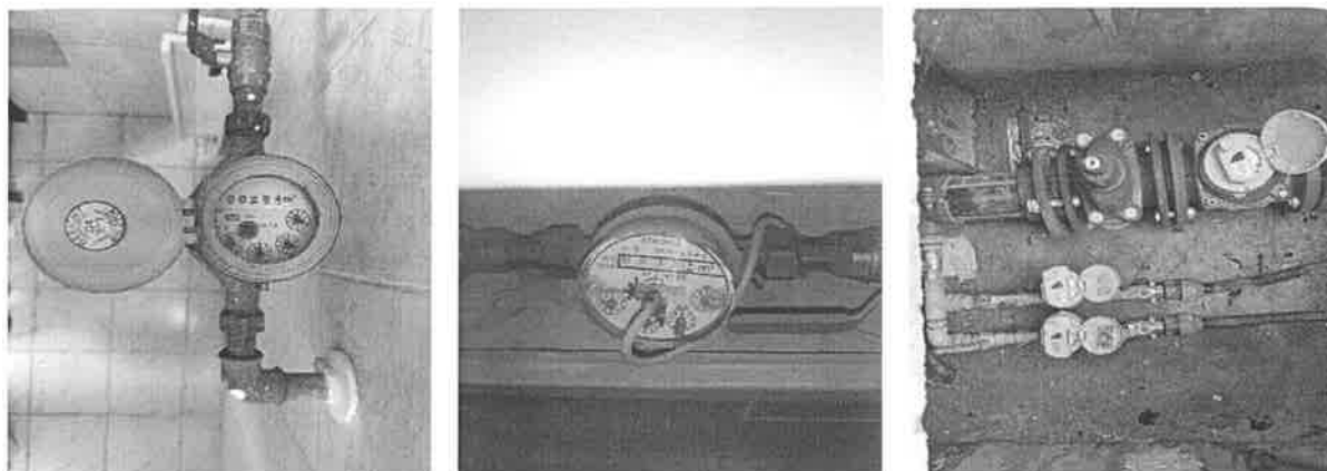
Slika 3. Različite vrste vodomjera: obični vodomjer (slika lijevo), apartmanski vodomjer sa MBUS sistemom očitavanja (slika u sredini) i radijski šahtovski vodomjeri različitih profila (slika desno)
