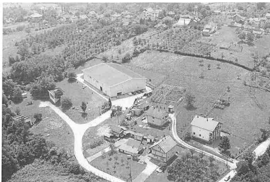
Slika 7. Postrojenje za interventno snabdijevanje Grada vodom na Ceriku
